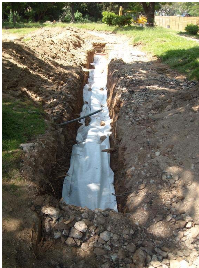
Vista general de la protecció de les estructures del sondeig 1100
