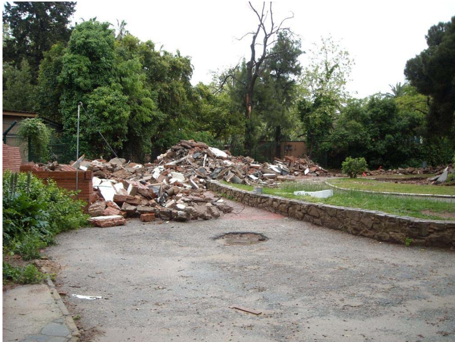
Vista general dels edificis enderrocats
